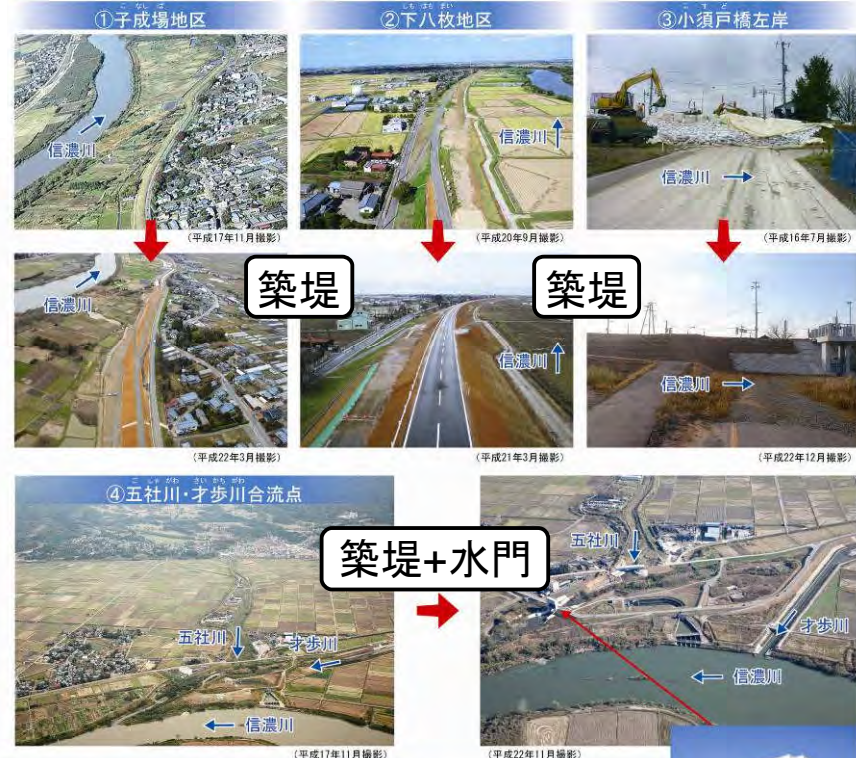
整備前・整備後写真(小阿賀野川から加茂川合流点)
