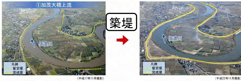
整備前・整備後写真 (加茂川合流点から上流)
