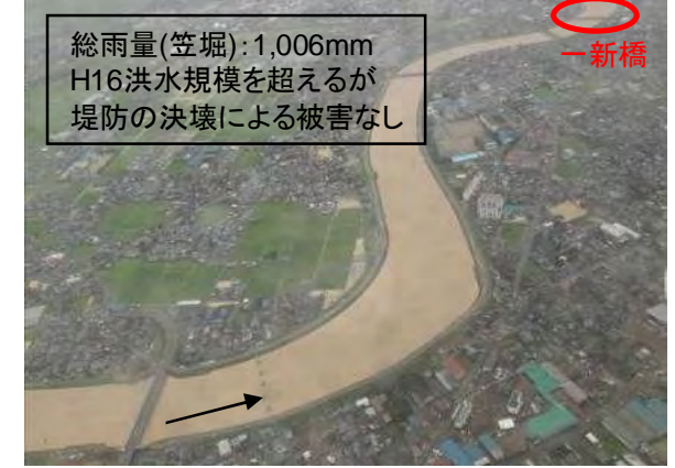
平成23年7月 出水の状況(30日13時頃)
